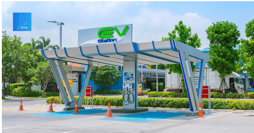
ภาพตัวอย่างสถานีชาร์จไฟฟ้า (Charging Station)
